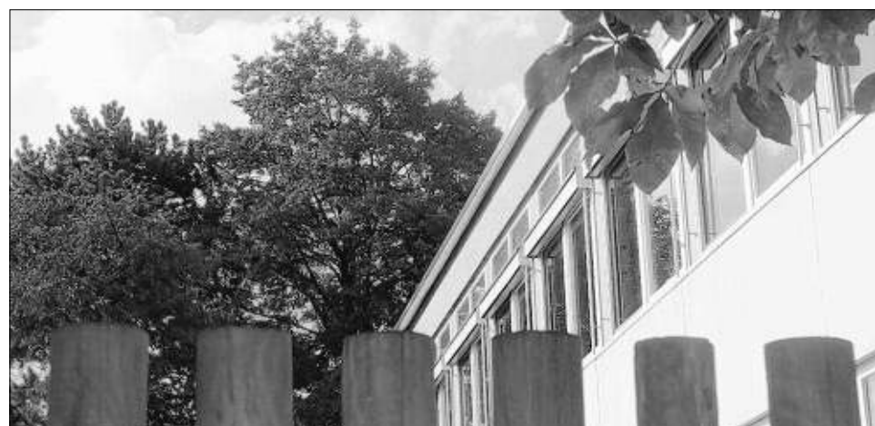
Weil große Bäume ihre Schatten auf einen Teil des Dachs werfen, werden jetzt nur halb so viele Photovoltaikmodule installiert wie ursprünglich geplant. Foto: Alexandra Kratz
