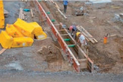
Die Bauarbeiter schieben die Schaltafeln hinein, damit der Beton später nicht rausläuft.
